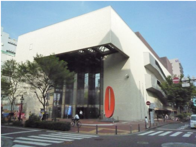
関内ホール全景
